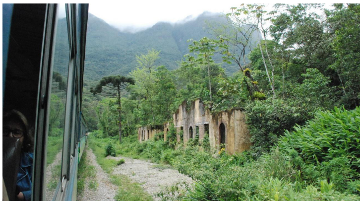
Figura 21. Estação em Ruínas (outubro/2018)
