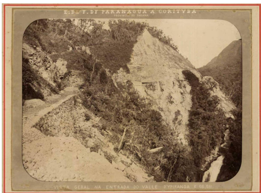
Figura 3. Vista Geral na Entrada do Valle D'Ypiranga K.66,511 (Marc Ferrez)
