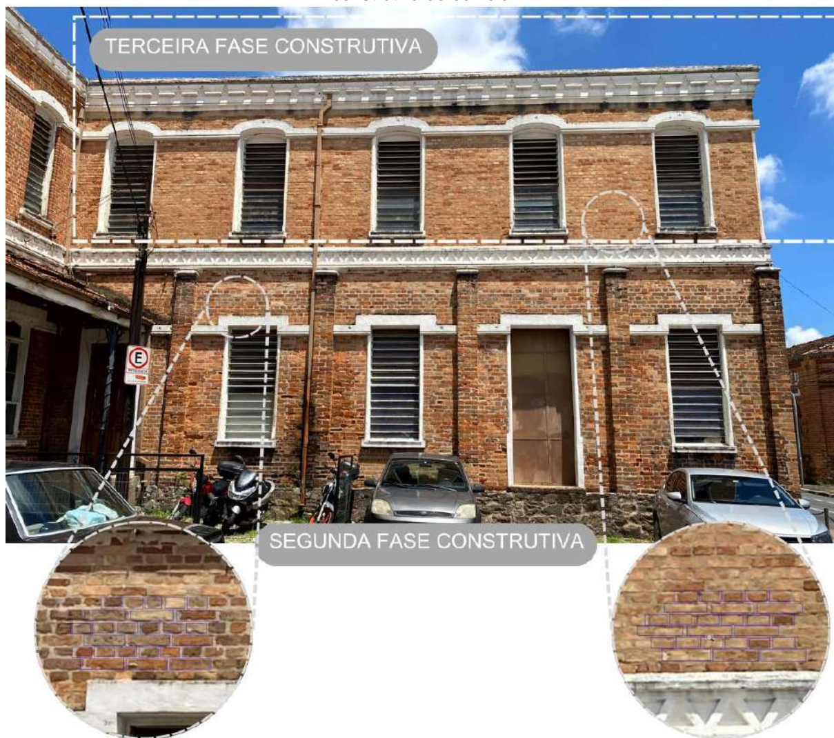
Figura 69 - Detalhe do aparelho inglês presente no encontro dos volumes da segunda e terceira fase construtiva do edifício.
