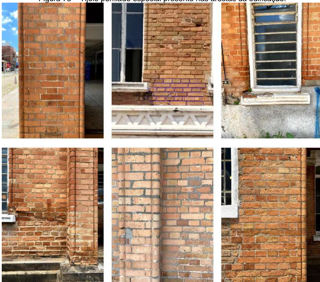
Figura 75 – Tijolo perfilado especial presente nas arestas da edificação.
