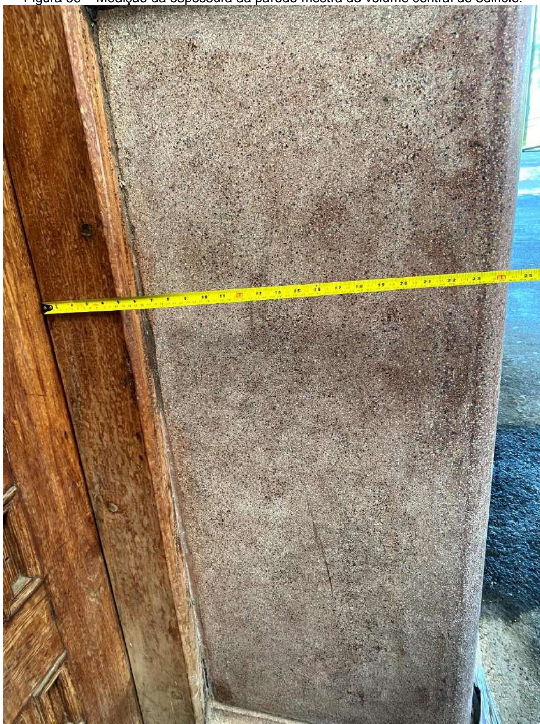
Figura 56 – Medição da espessura da parede mestra do volume central do edifício.
