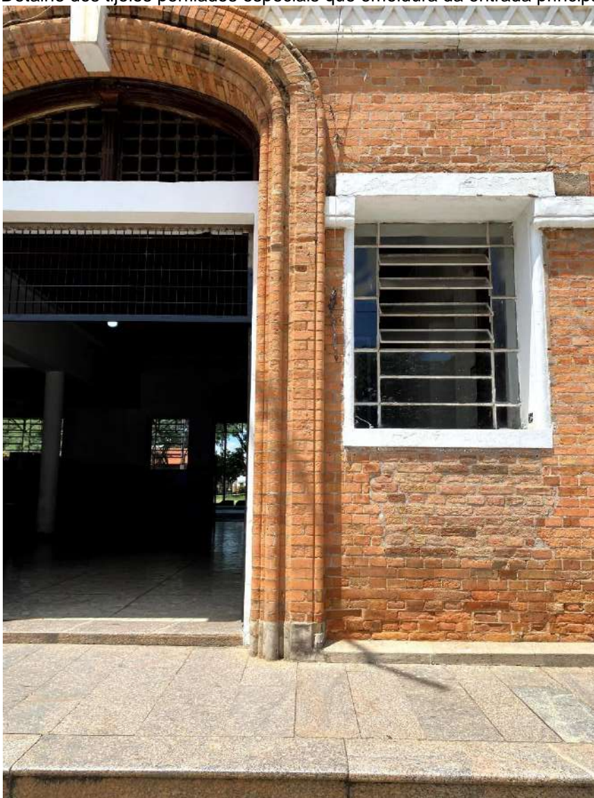
Figura 77 – Detalhe dos tijolos perfilados especiais que emoldura da entrada principal do edifício.
