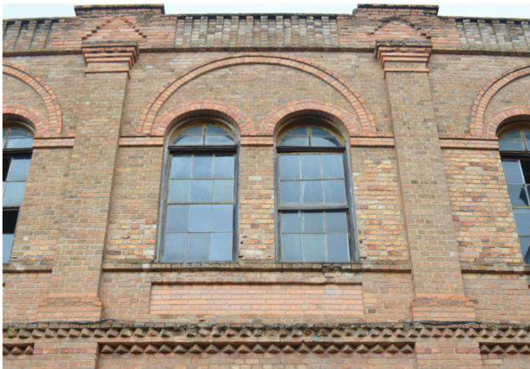
Figura 12 - Paredes e ornamentos em tijolos nas oficinas da CPEF e Jundiaí.
