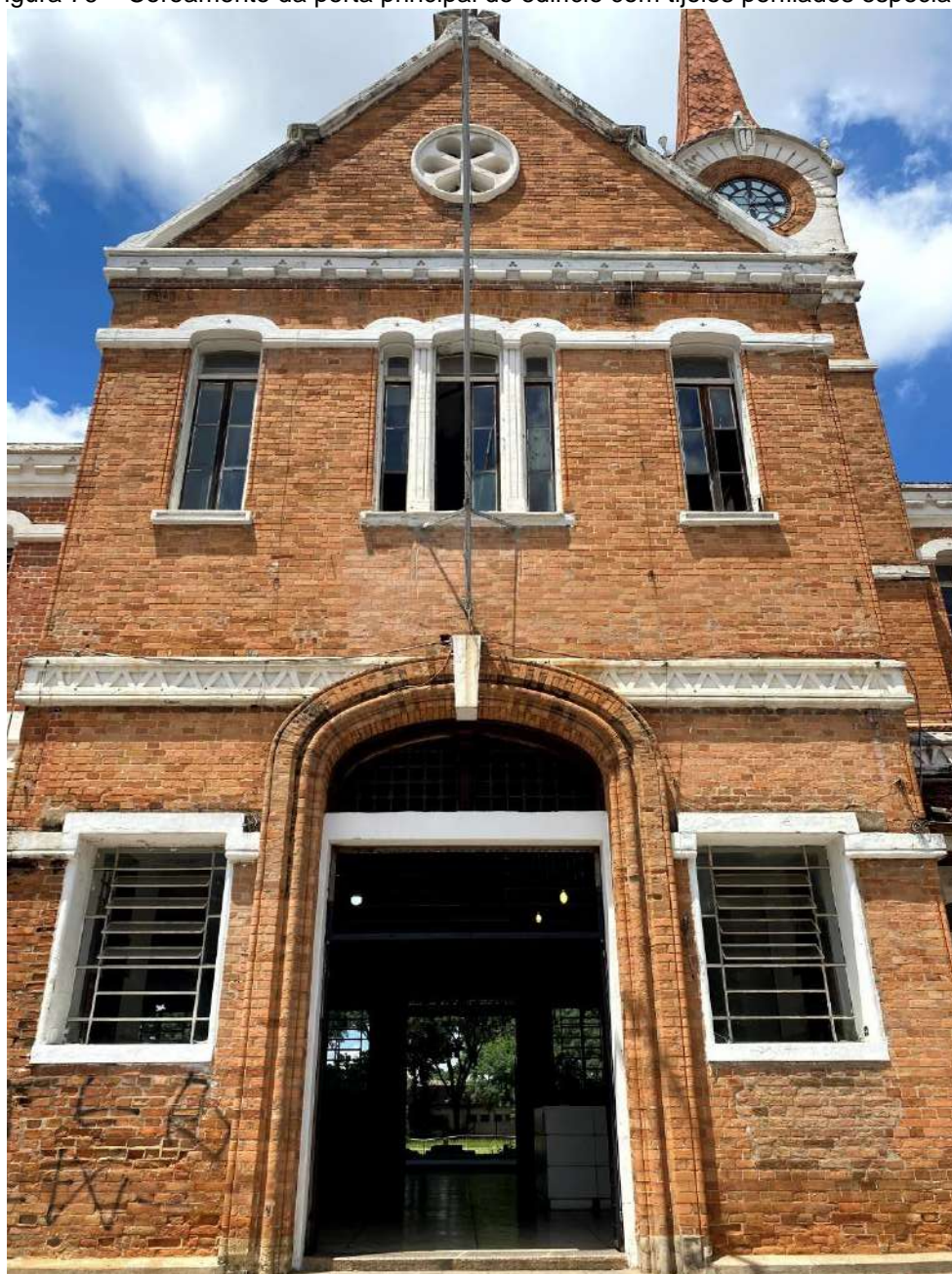
Figura 76 – Coroamento da porta principal do edifício com tijolos perfilados especiais.
