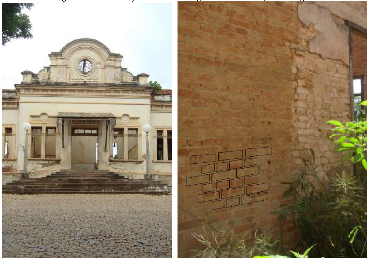
Figura 65 e 66 - Estação de Dois Córregos e detalhe do aparelho inglês.
