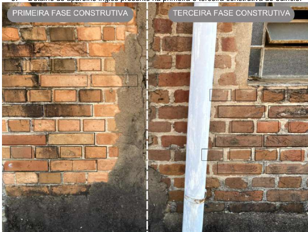
67 – Detalhe do aparelho inglês presente na primeira e terceira construtiva do edifício.
