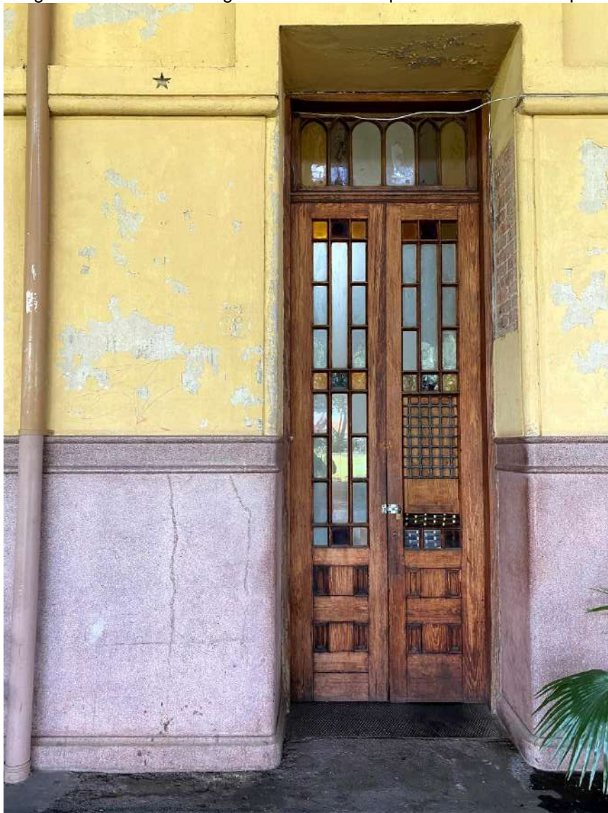
Figura 34 – Barrado em granilite na área da plataforma de embarque.
