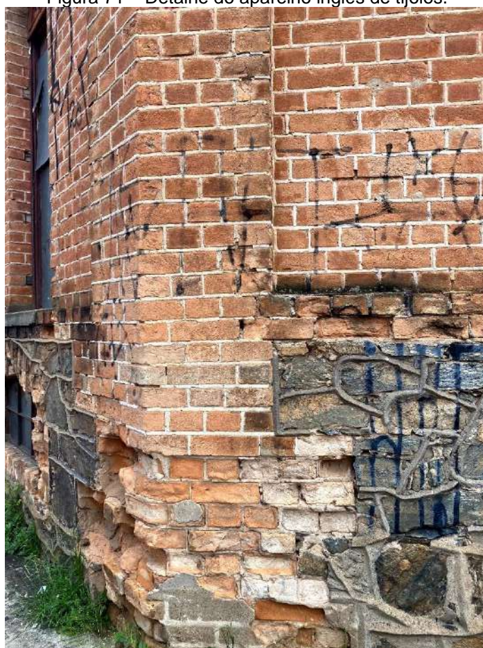
Figura 71 – Detalhe do aparelho inglês de tijolos.
