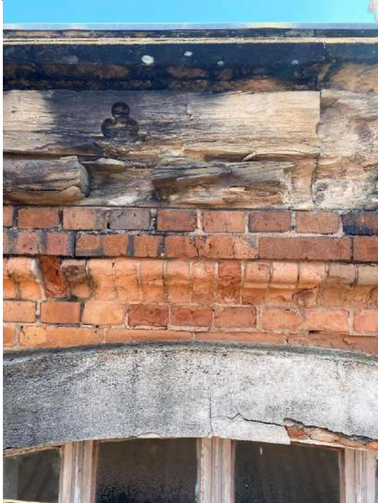
Figura 72 – Arremate em tijolos abaixo da cornija.
