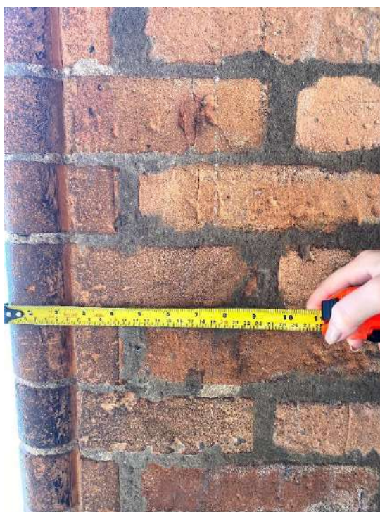
Figura 53, 54 e 55 – Tijolo perfilado especial da primeira fase construtiva da edificação.
